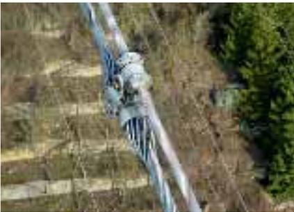
*Eine Klemme an einer Hochspannungsleitung, die zu Inspektionszwecken angeflochten wurde*
